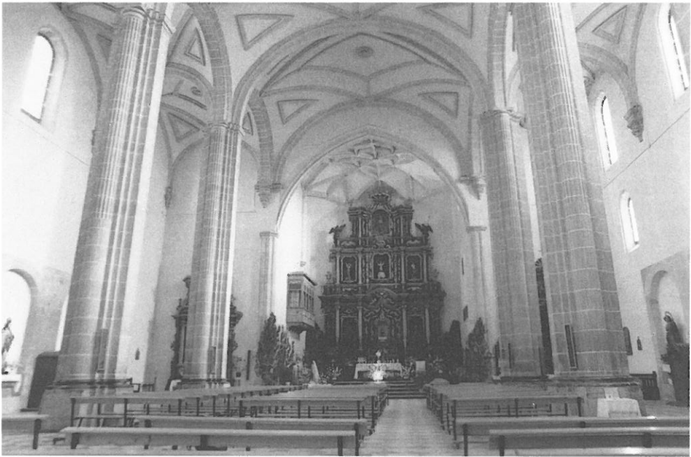
Lámina 5. Interior de la iglesia de Puebla de don Fadrique.
