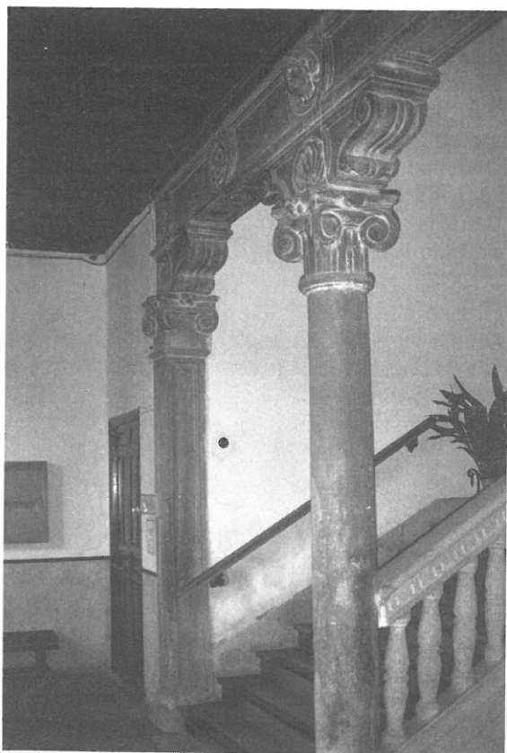
Lámina 6. Escalera, galería inferior (casa del marqués de Malpica, Toledo).
